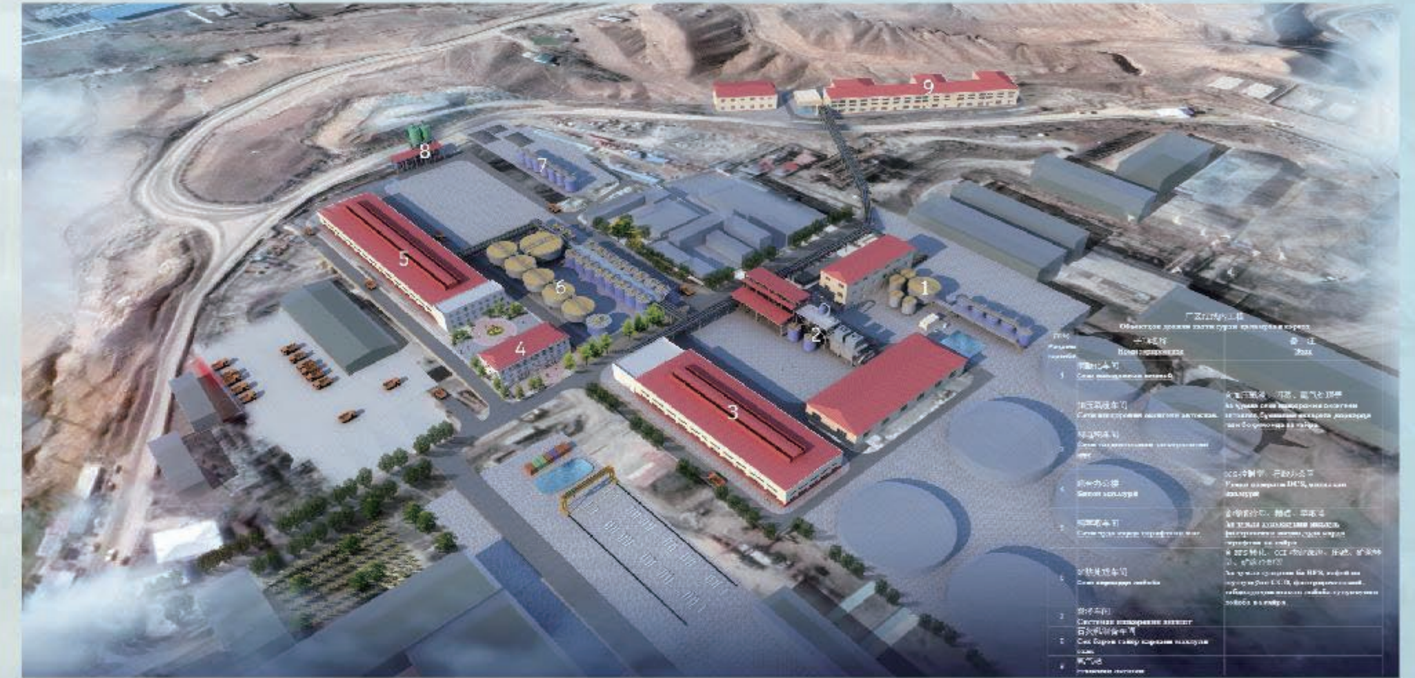
塔吉克斯坦塔罗金矿500t/d加压氧化项目 500t/d Pressure Oxidation Project of Taror Gold Mine in Tajikistan
