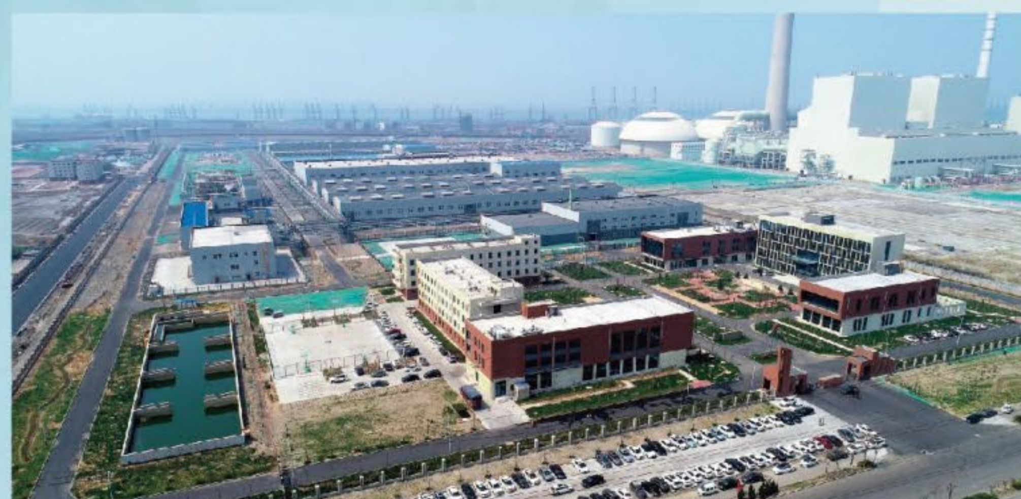
中冶新材料项目 MCC Ramu's Ternary Precursor Project
