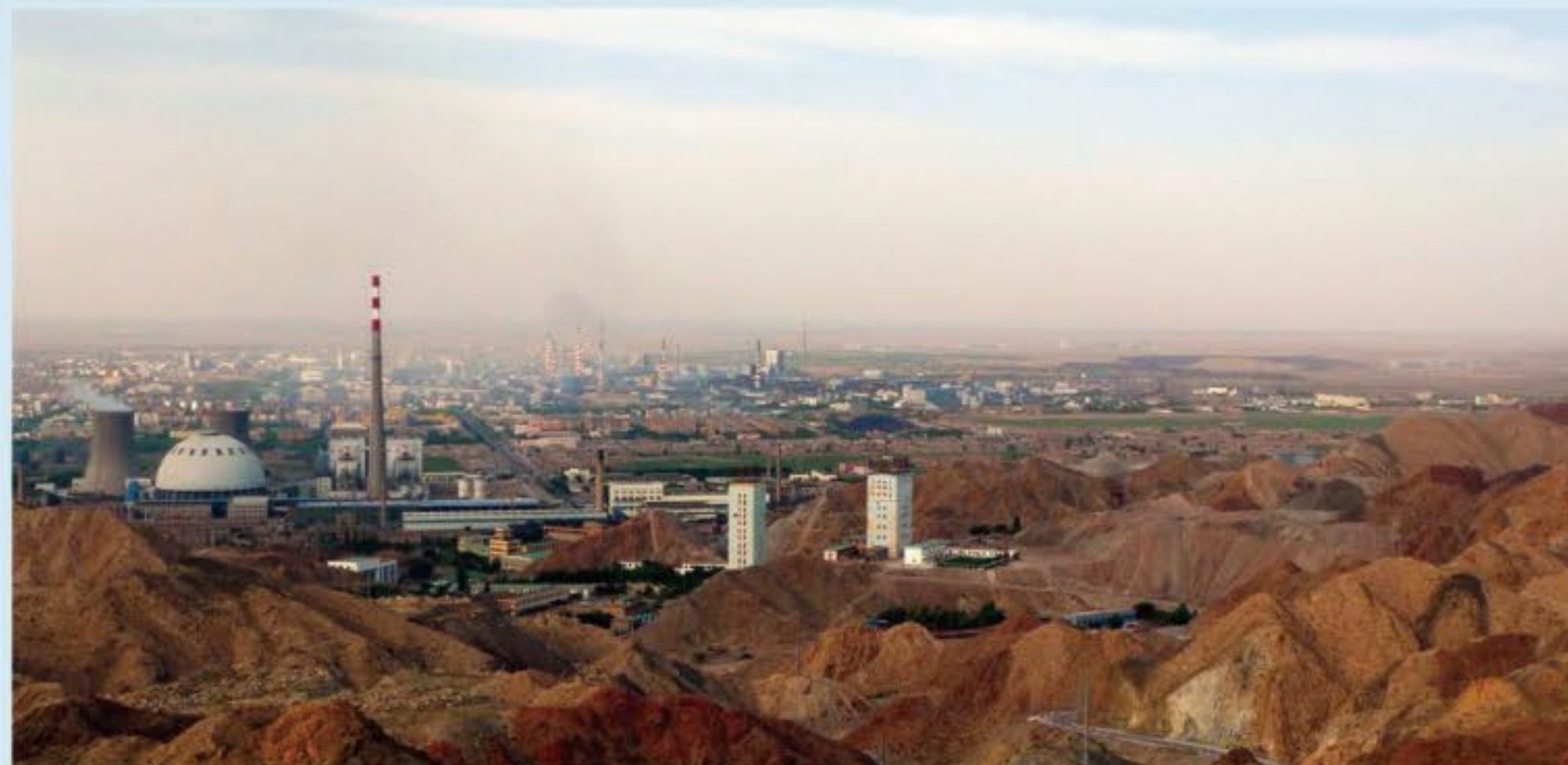
金川工程 Jinchuan Project
